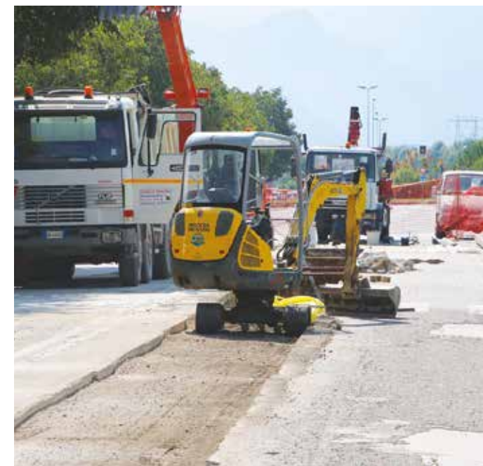
Si lavora per la posa del teleriscaldamento a Cuneo
